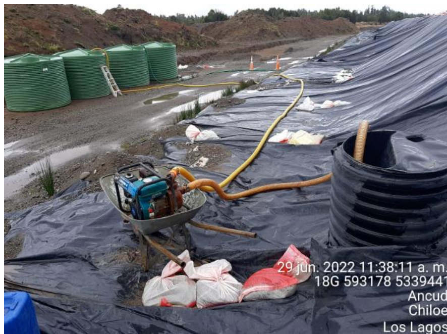
Fotografía N°5: Extracción de Lixiviados desde C12 por personal municipal. Tomada: Miércoles 29 de Junio del 2022.
