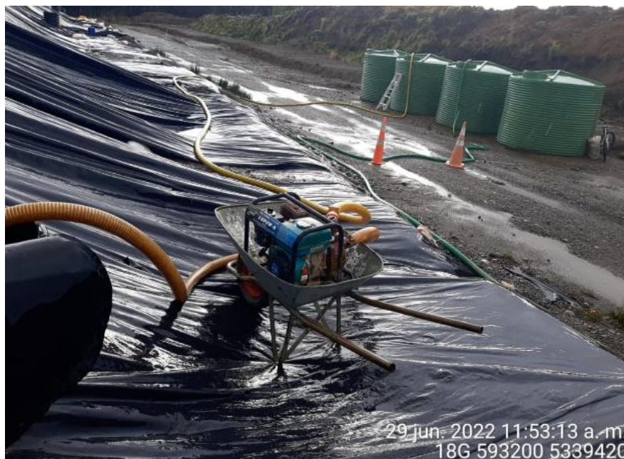
Fotografía N°4: Extracción de Lixiviados desde C13 por personal municipal. Tomada: Miércoles 29 de Junio del 2022.
