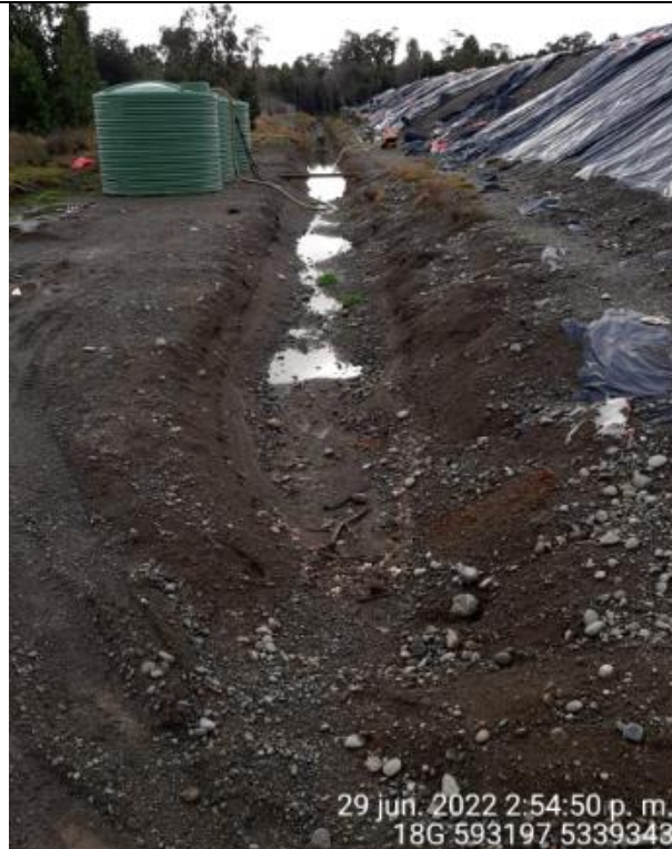
Fotografía N°46: Estado canales aguas lluvias
