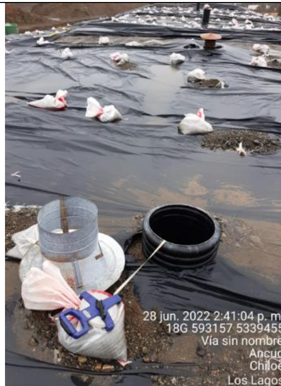
Fotografía N°33: Medición de Niveles de cámaras por Personal Municipal. Tomada: 28 de Junio del 2022.
