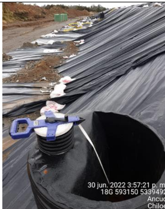
Fotografía N°35: Medición de Niveles de cámaras por Personal Municipal. Tomada: 30 de Junio del 2022.
