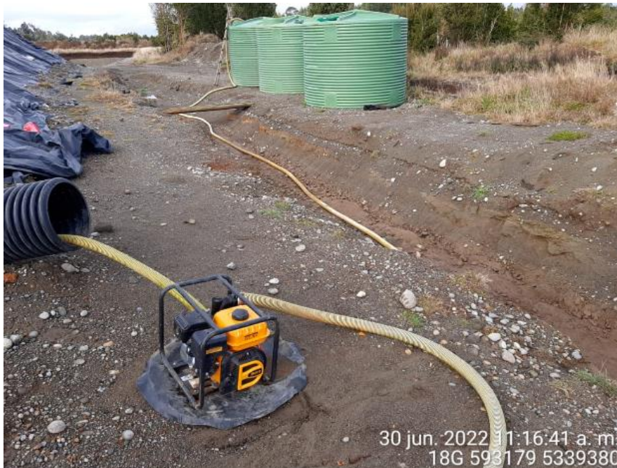
Fotografía N°6: Extracción de Lixiviados desde diagonal D02 por personal municipal. Tomada: Jueves 30 de Junio del 2022.
